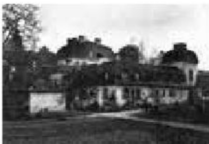
Oekonomiegebäude um 1900 Ansicht West (Archiv Kant. Denkmalpflege)
