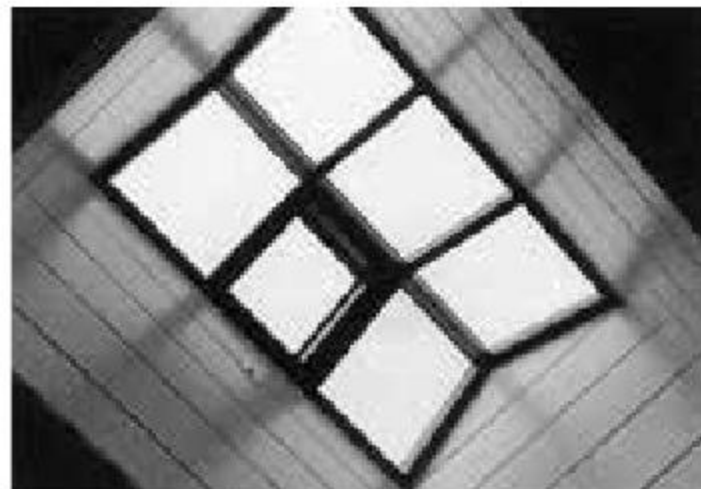
Oblicht Eckrisalit Dachgeschoss
