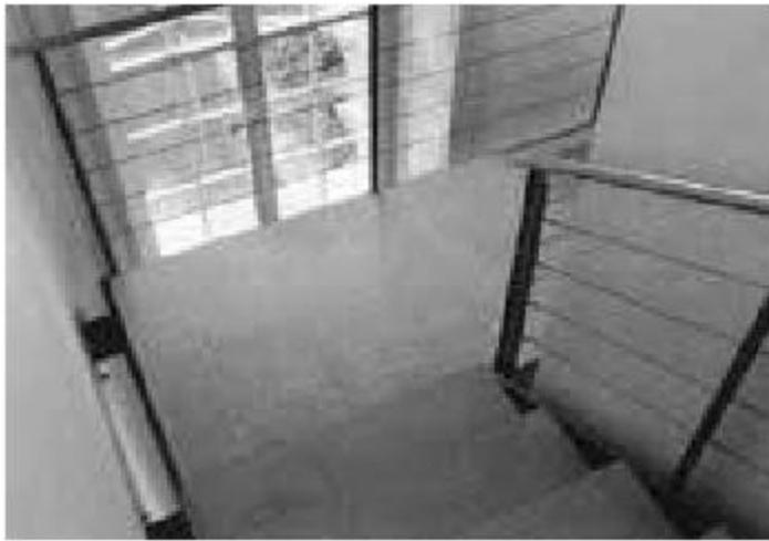
Neues Treppenhaus Eckrisalit Nord-West
